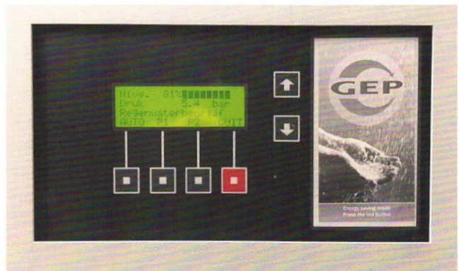
Display der Regenwasseranlagensteuerung | Foto: © GEP
