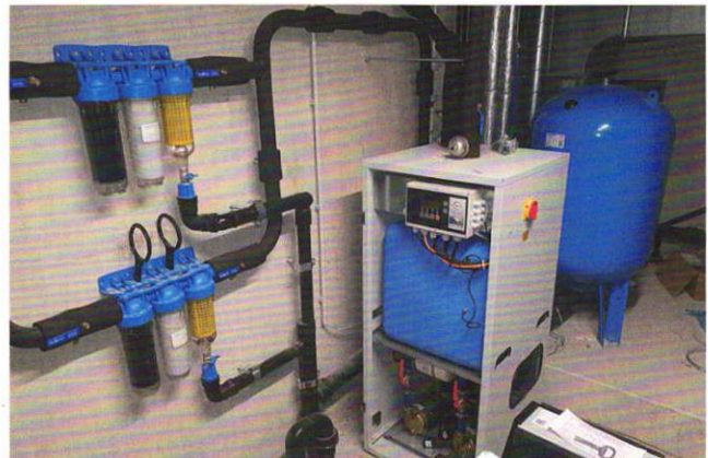
IRM-Pumpenanlage | Foto: © GEP
